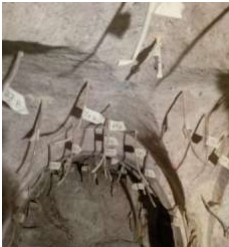
Fig.13: Primo intervento: iniezioni a base di miscele idrauliche per il consolidamento della volta.
