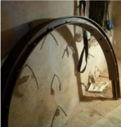
Fig. 19: L'arco calandrato in acciaio prima della posa.
