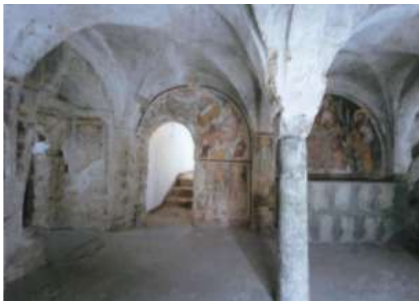
Fig.31: La cripta prima dei lavori.
