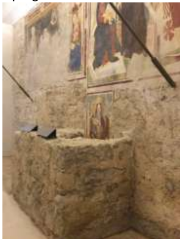
Fig.29: Il contrafforte, parzialmente rimosso, ha messo in luce un affresco. La struttura di rinforzo è stata realizzata in profili d'acciaio e barre.
