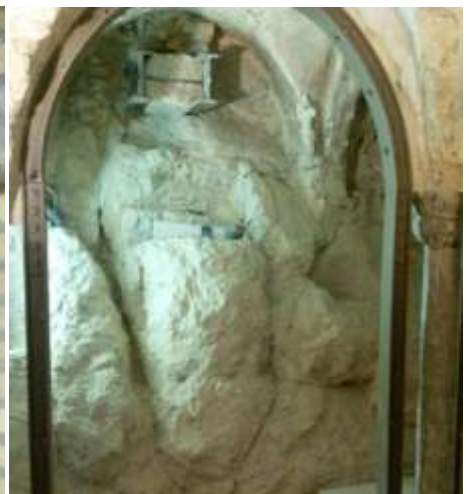
Fig.26: Il "gazebo" concluso e le travi orizzontali rimosse. Un piccolo spezzone di trave è stato lasciato nella roccia "a memoria" delle vicende costruttive della Cripta.
