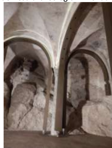
Fig.35: La cripta con il "gazebo strutturale" concluso.
