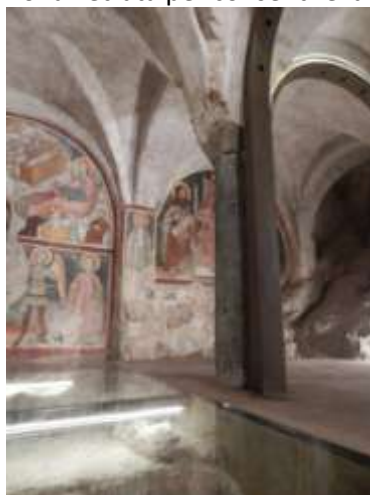
Fig.34: La cripta con il "gazebo strutturale" concluso.
