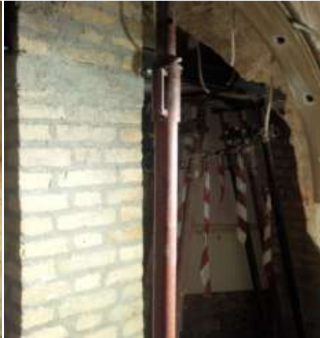
Fig.20: Posa in opera del "gazebo" strutturale.
