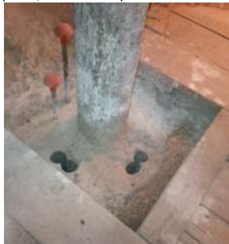
Fig.17: Carotature per realizzare la fondazione di appoggio del "gazebo strutturale" in corrispondenza delle colonnine in pietra. Nei fori sono stati inseriti micropali inox.
