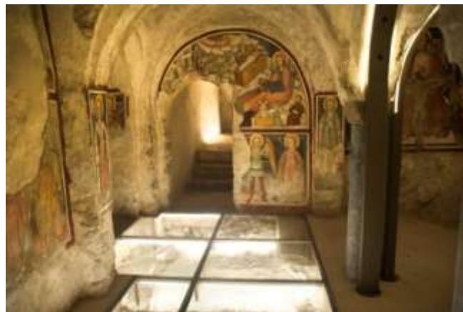
Fig.29: Il contrafforte, parzialmente rimosso, ha messo in luce un affresco. La struttura di rinforzo è stata realizzata in profili d'acciaio e barre.
