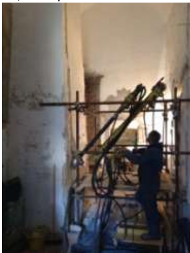
Fig.28: Le perforazioni del contrafforte in pietra, nel corridoio di accesso alla cripta, prima della sua parziale rimozione
