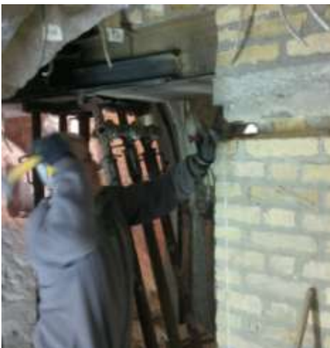
Fig.25: La demolizione dei pilastri degli anni '30 e la rimozione delle travi di sostegno
