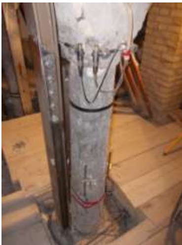
Fig.22: Al termine della posa in opera del "gazebo" le colonnine in pietra e gli archi in acciaio sono stati strumentati mediante strain gauges per misurarne lo stato di sollecitazione prima, durante e dopo la messa in forza del sistema.
