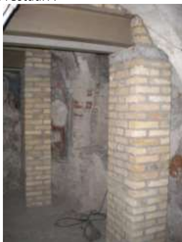
Fig.7: Negli anni '30 del Novecento vengono introdotti rinforzi intradossali, costituiti da nuovi pilastri in muratura e travi orizzontali miste, in acciaio-calcestruzzo.
