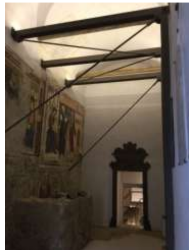
Fig.30: La struttura di rinforzo in acciaio che consente di mantenere in sicurezza la parete affrescata, ad opere concluse.
