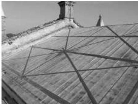
Figura 2. Intervento di consolidamento strutturale realizzati sulla copertura del Duomo di Colorno
