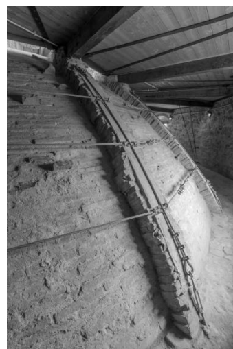
Figura 10 – Realizzazione dell’intervento di consolidamento della cupola di Santa Caterina a Lucca
