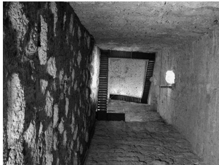
Figura 2 – Interno della torre prima dei lavori
