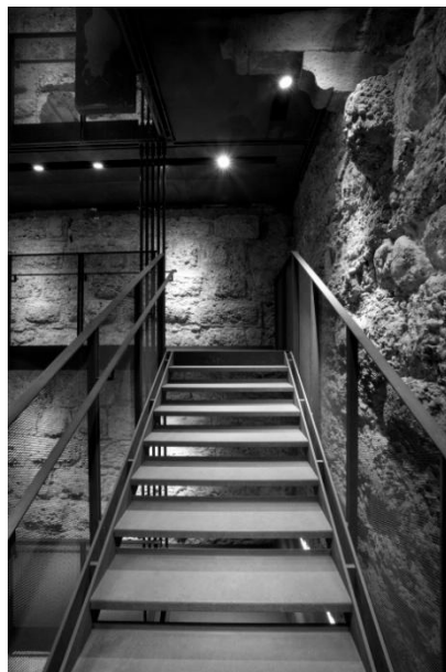
Figura 4 – Particolare della nuova scala
