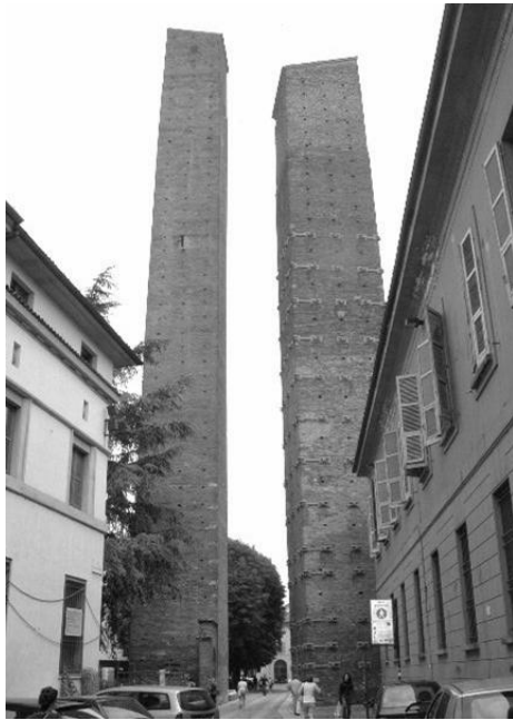
Figura 5 – Torre del Maino(sx) e Torre Fraccaro (dx) a Pavia Errore. L'origine riferimento non è stata trovata.
