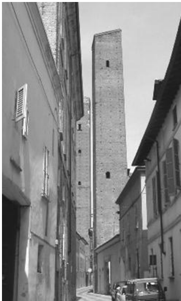
Figura 3 - Torre San Dalmazio, vista del fronte meridionale
