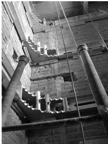
Figura 10 - Girelli metallici interni alla torre del Maino e giunto “a festoni”
