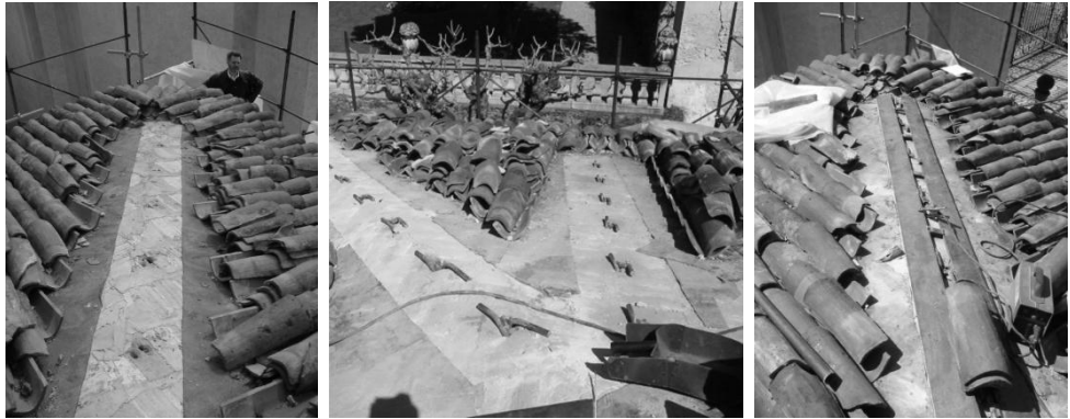
figg. 8a; 8b; 8c - Villa della Porta Bozzolo a Casalzuigno fasi dell'intervento all'estradosso
