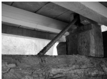
figg. 7a; 7b; 7c - Villa della Porta Bozzolo a Casalzuigno a) e b) consolidamento delle travi di copertura c) prova di carico su un elemento ricostruito a piè d'opera
