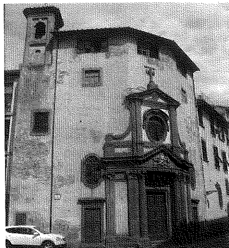
Fig. 1 - La Chiesa di Santa Caterina a Lucca prima dell'inizio del cantiere
