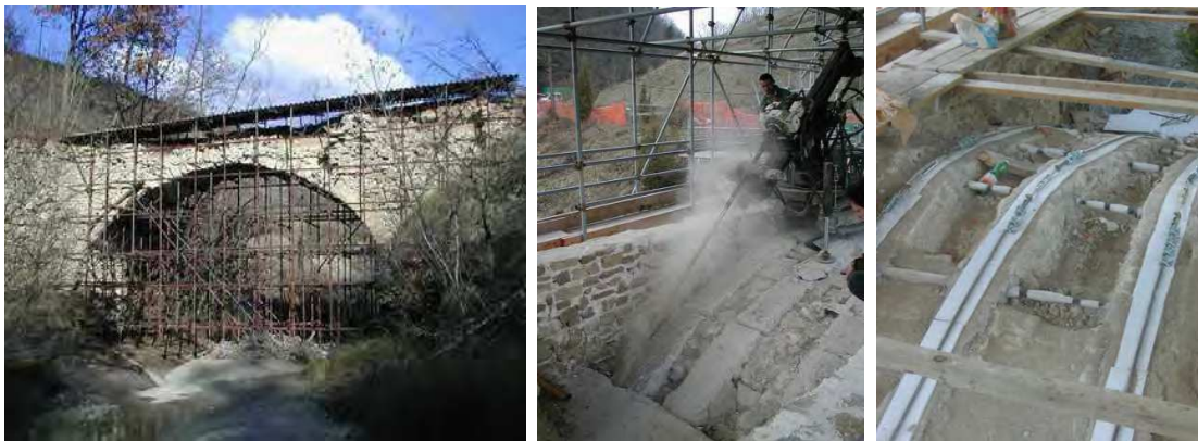
Figura 22. Immagini del ponte sul fiume Uso prima e durante i lavori di consolidamento con l'uso di 3 cavi inox.
