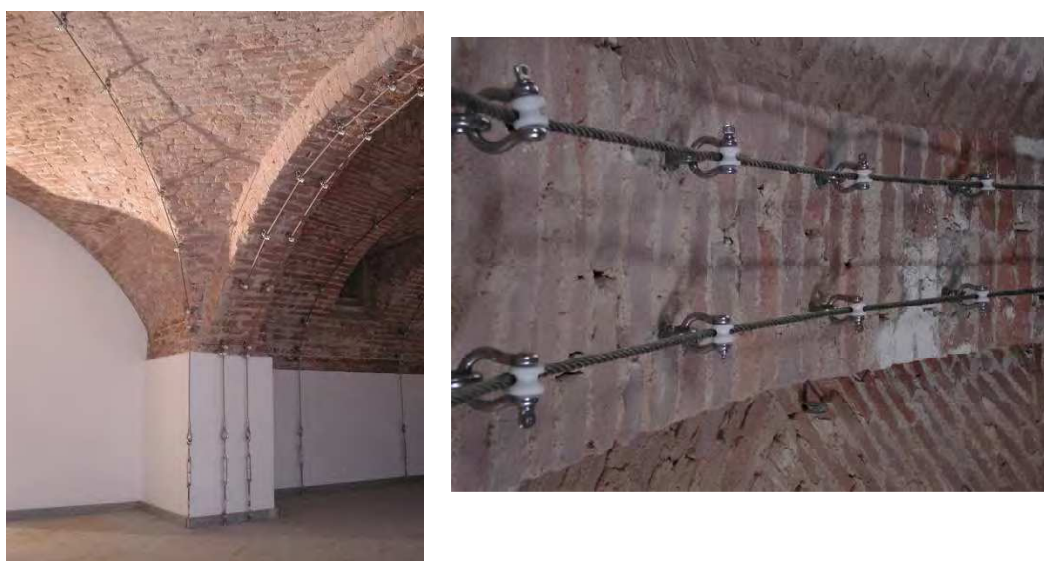
Figura 25. Consolidamento delle volte di Villa Borromeo a Senago (MI) con “arco armato” intradossale.
